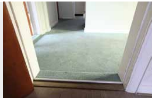
Bodenbeläge vor dem Umbau
