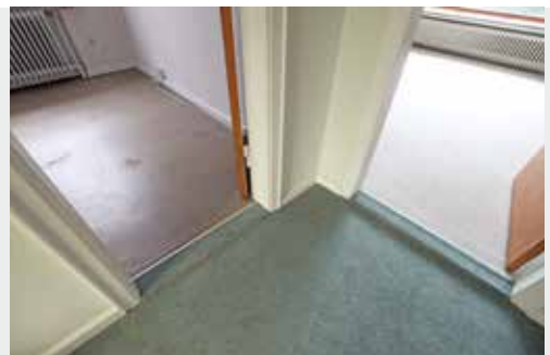
Türen vor dem Umbau
