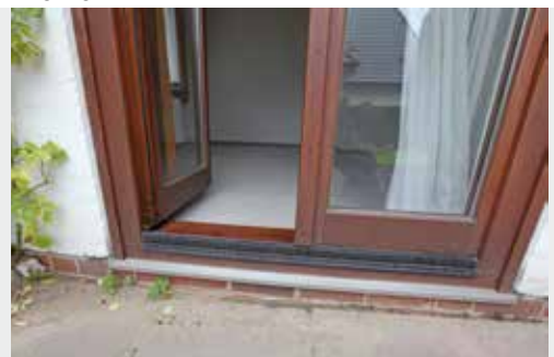
Zugang zur Terrasse vor dem Umbau
