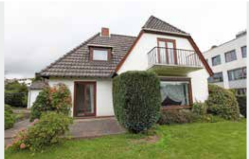
Terrasse vor dem Umbau
