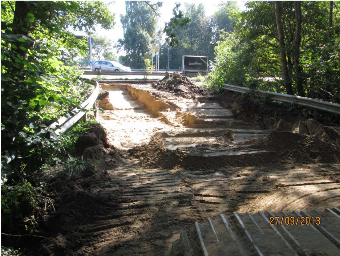
Abbildung oben: Die Asphaltdecke der ehemaligen Stichstraße an der B 74 ist bereits entfernt. Unter ihr befand sich ein 8 m langes DN 1000 Betonrohr mit einem am Auslass des Rohres befindlichen Absturz.
